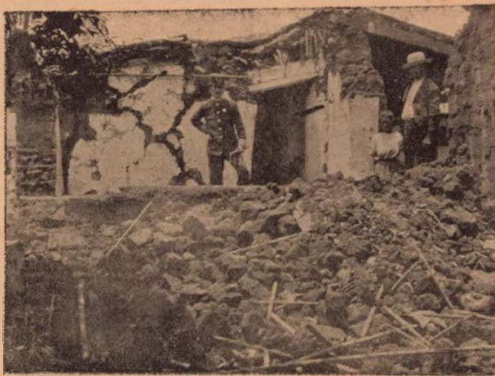
Casa destruída por los temblores en Cartago durante la noche del 13 de abril próximo pasado
