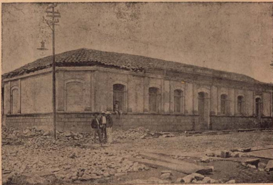
Casa de Cartago dañada por los temblores del día 13 de abril último
